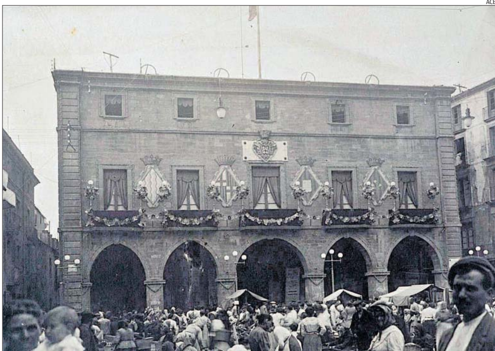
Façana de l'ajuntament a la segona dècada del segle XX
